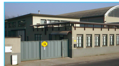
I capannoni di via Edison
